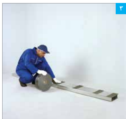
اجرای نوار عایق بر روی استاداها
