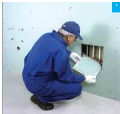
قرار دادن پنل دریچه در درون قاب
