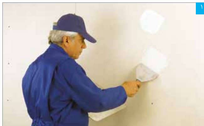
اجرای بتونه در محل پیچ‌ها
