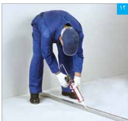
۱۲ اجرای دو ردیف خمیر سیلیکون (یا نوار عایق) بر پشت جان استادهای جانبی
