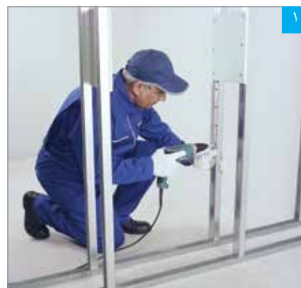
اتصال قطعات نبشی L25 به استادهای مجاور
