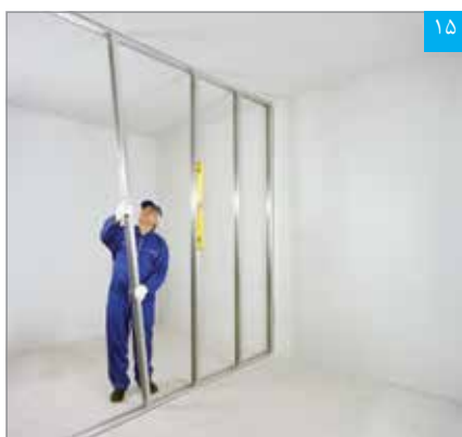
اجرای استاداها (به صورت شاقولی)
