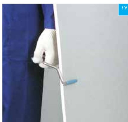
حمل پنل به سادگی با گیره مخصوص و توسط دو نفر انجام می‌شود
