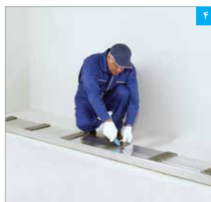
برش نوارهای عایق
