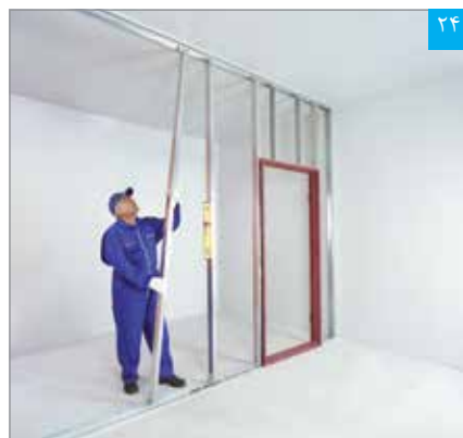
اجرای استادهای دیوار
