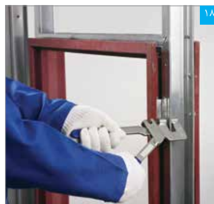
اتصال رانر نعل درگاه به استادهای با پانچ
