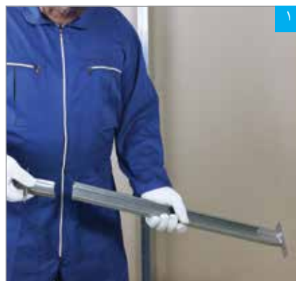
قطعه اتصال SC47 به صورت کشویی در سازه F47 قرار می‌گیرد
