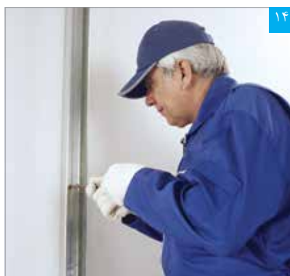
اتصال استاد به دیوار بنایی با رول پلاگ
