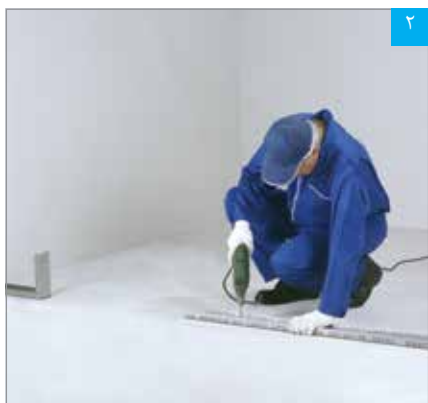
نصب رانر کف
