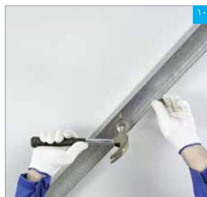
۱۰ اتصال رانر به سقف با رول پلاگ
