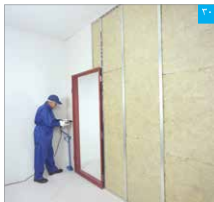
پیچ‌زنی پنل در حاشیه دور چهارچوب
