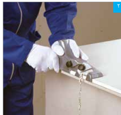
اجرای پخ با پخ زن
