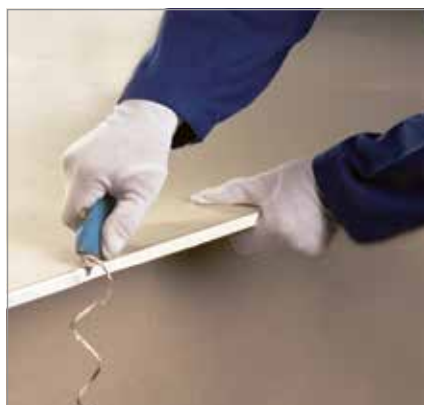
اجرای پخ با تیغ برش
