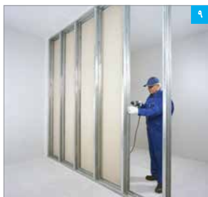
اجرای پنل‌ها در یک طرف دیوار
