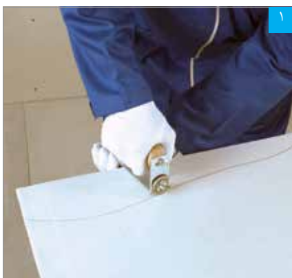
اجرای برش موج‌دار با دستگاه برش قرقره‌ای
