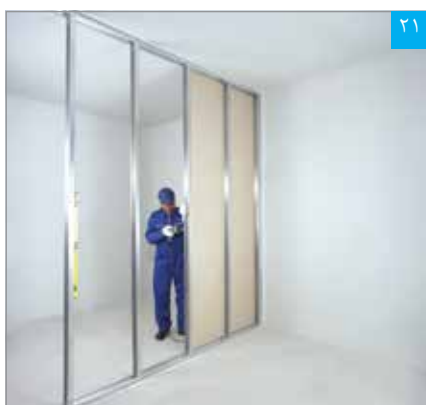
اجرای پنل‌ها در یک طرف دیوار
