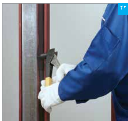
رانر تقویتی توسط پرچ به استاد متصل می شود
