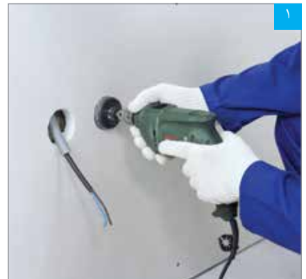
۱ خروجی‌های تاسیساتی به وسیله گردبر ایجاد می‌شوند
