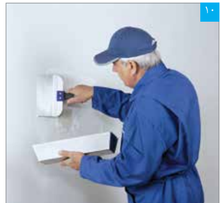
بتونه کاری درزها در محل ترمیم (با استفاده از نوار و بتونه درزگیر)
