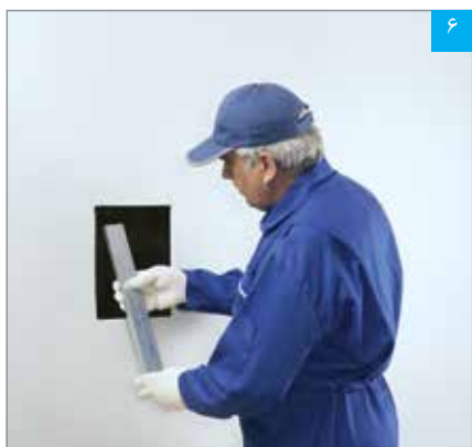
قرار دادن قطعه پروفیل در درون دیوار به منظور ایجاد زیرسازی در محل آسیب دیده
