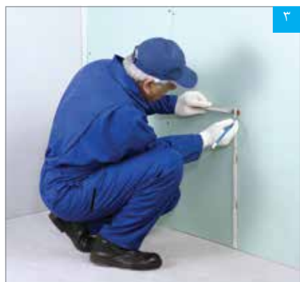
تعیین محل خروجی‌های تاسیساتی
