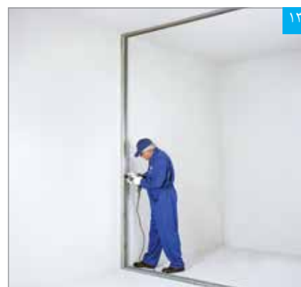
نصب استاد بر روی ساختار جانبی (سوراخ کردن استاد و دیوار)
