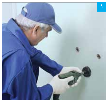
خروجی‌های تاسیساتی به وسیله گردبر ایجاد می‌شوند
