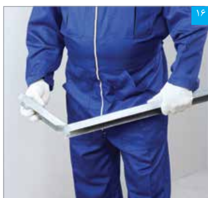
خم کردن انتهای رانر نعل درگاه
