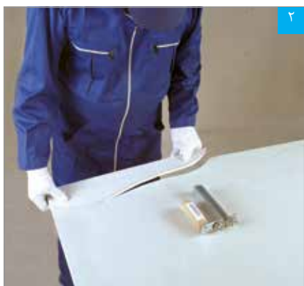
جداکردن پنل از محل برش
