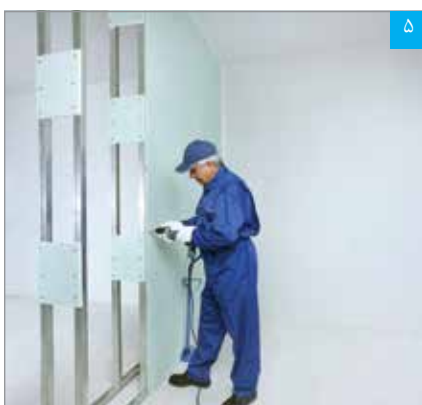
اجرای پنل‌ها در یک طرف دیوار
