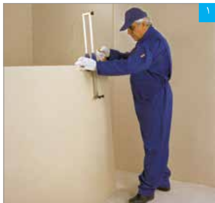
برش پنل با دستگاه برش طولی
