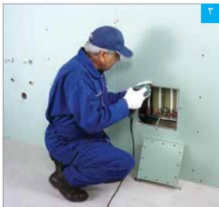
اتصال قاب دریچه
