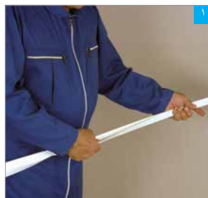
خم کردن نوار درزگیر با دست
