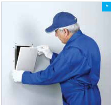
قرار دادن قطعه پنل جایگزین در محل خود
