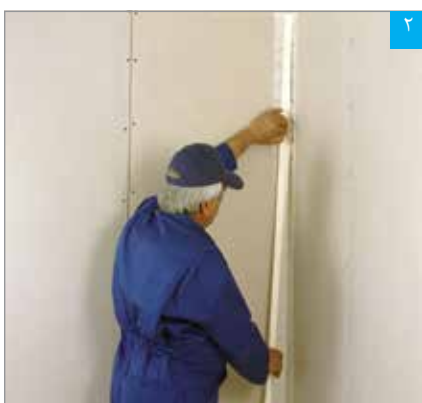
قرار دادن نوار درزگیر بر روی بتونه
