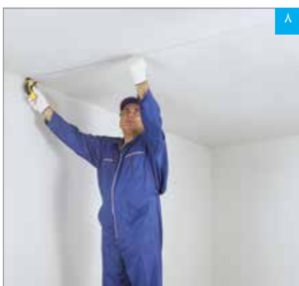
۸ مشخص کردن محل نصب رانر سقف با ریسمان رنگی
