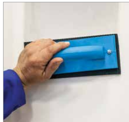
مرطوب کردن سطح دیوار با اسفنج نمدار
