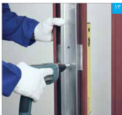
چهارچوب توسط پیچ LB در محل صفحات نصب به استادهای متصل می شود
