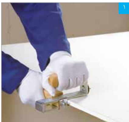
برش پنل با دستگاه برش قرقره‌ای
