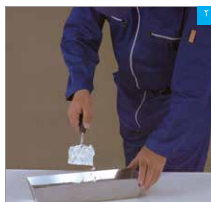
ریختن پودر بتونه در آب
