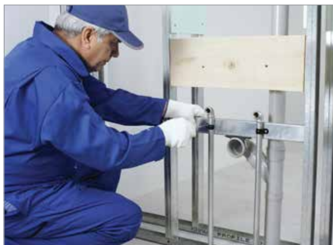
اتصال لوله‌های تاسیساتی به سازه پشتیبان SP60
