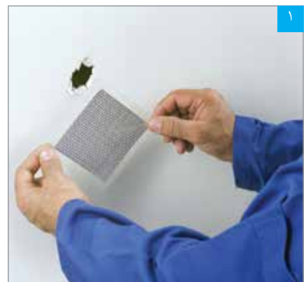
قرار دادن وصله مخصوص پشت چسب دار بر روی محل آسیب دیده
