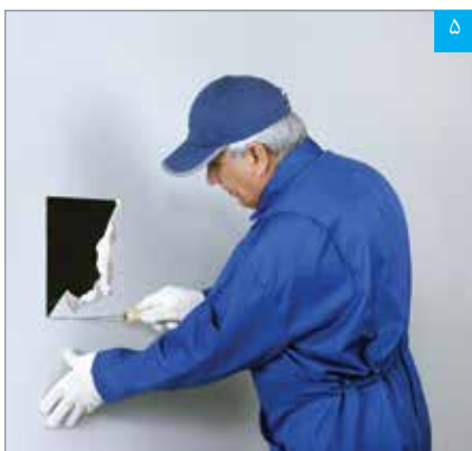
برش محل آسیب دیده به شکل قطعه ترمیمی
