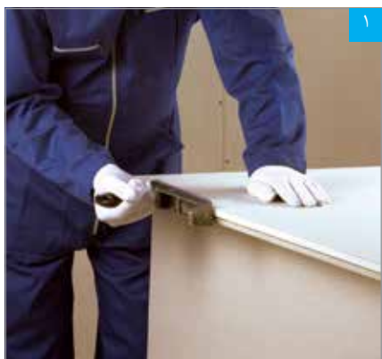
پرداخت لبه برش خورده با رنده
