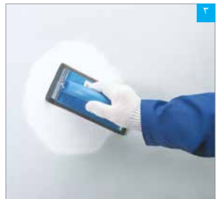
پرداخت سطح بتونه کاری شده و آماده سازی جهت پذیرش پوشش نهایی
