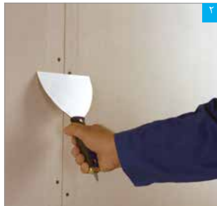
۲ بررسی بیرون زدگی پیچ‌ها با کاردک
