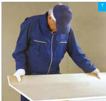
شکستن پنل در محل برش
