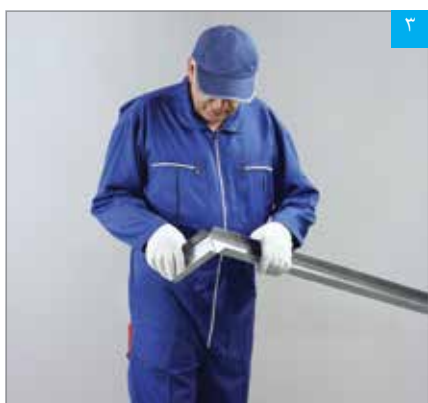
۳ پس از برش بال‌ها، رانر خم و راست شده تا از محل جان برش بخورد
