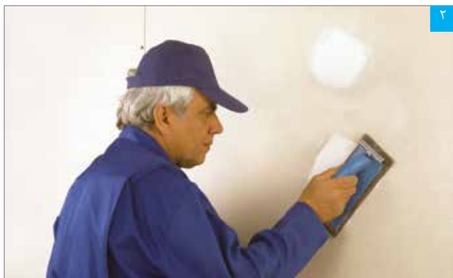
پرداخت سطح بتونه خشک
