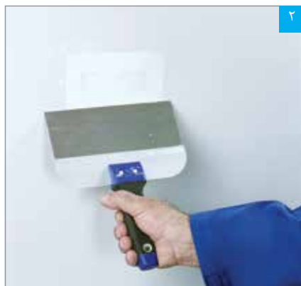
اجرای بتونه بر روی وصله ترمیمی
