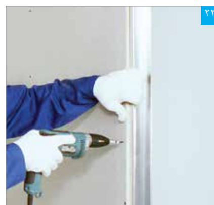
پنل باید در جهتی نصب شود که لبه آزاد آن به سمت دهانه باز استاد قرار گیرد
