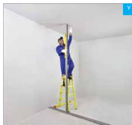
۷ انتقال تصویر رانر کف به سقف (با استفاده از استاد و تراز)
