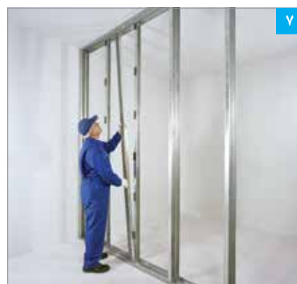
اجرای ردیف دوم استاداها
