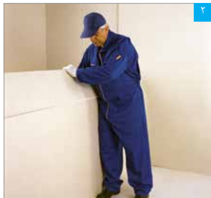
شکستن پنل در محل برش
