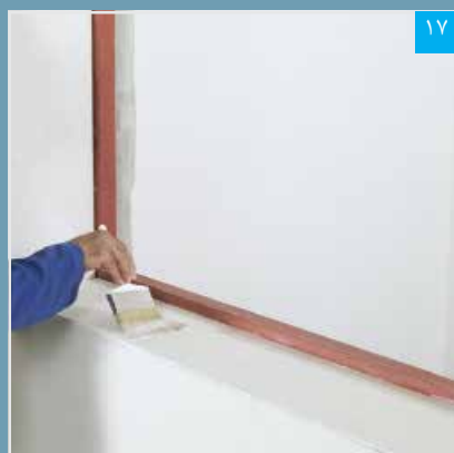
اجرای پرایمر بر روی سطح پنل
