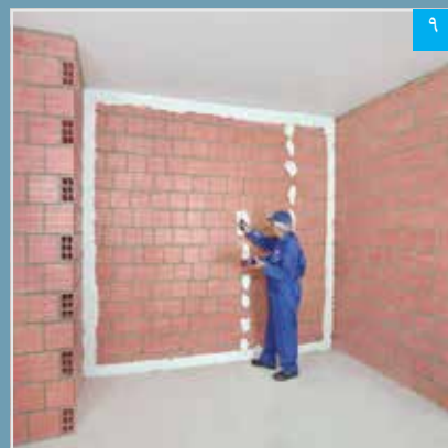
۱۰ اجرای چانه های پرفلیکس بر روی دیوار زمینه (در فواصل مرکز به مرکز حداکثر ۳۵ س.م)
