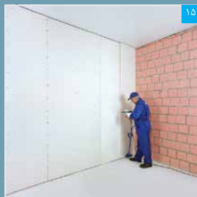
اجرای لایه دوم پنل‌ها؛ ساختار W625 (لایه دوم نسبت به لایه اول به صورت حصیرچین اجرا می شود)
