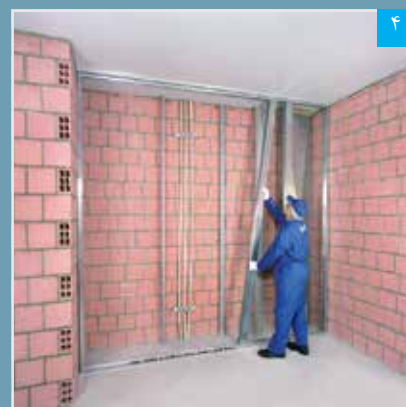
۳ استقرار استادهای دوتایی در رانرها (به صورت شاقولی)
