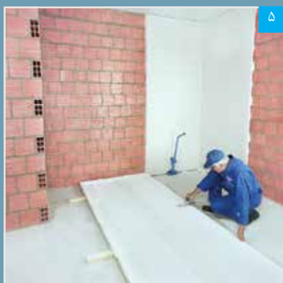
۵ اجرای لایه بتونه درزگیر (به صورت شانه‌ای) بر پشت پنل مرکب PS
