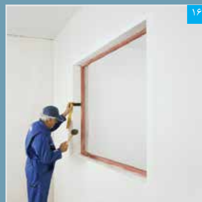
نصب و تنظیم پنل نواری
