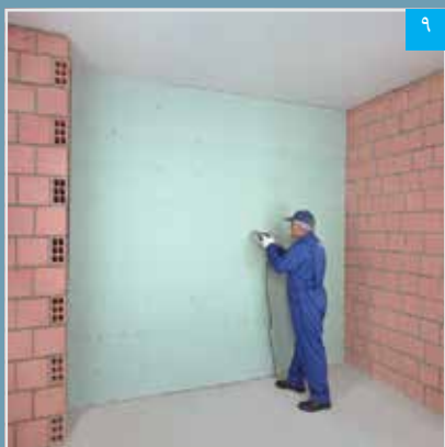
نصب لایه دوم پنل‌ها و تکمیل ساختار
