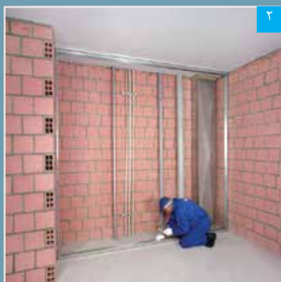
نصب استاد کف و تکمیل قالب پیرامونی
