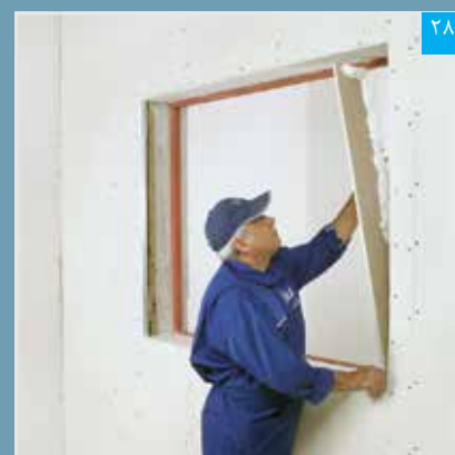
۲۸ استقرار پتل نواری در ناحیه داخلی دور بازشوی پنجره (به اجرای یکپارچه پرفیکس توجه شود)
