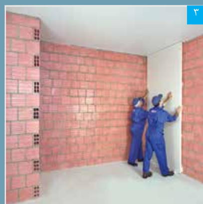
۳ استقرار پنل بر روی دیوار زمینه
