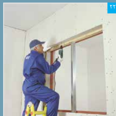
اتصال پنل نواری به سازه قاب بندی فوقانی
