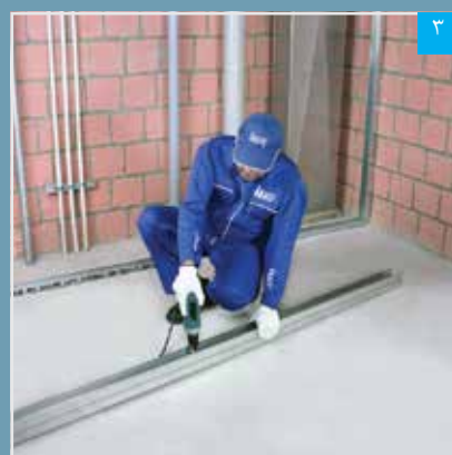
۷ اجرای استادهای دوتایی
