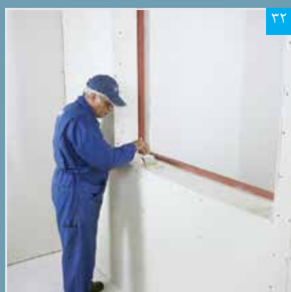
اجرای پرایمر بر روی سطح پتل
