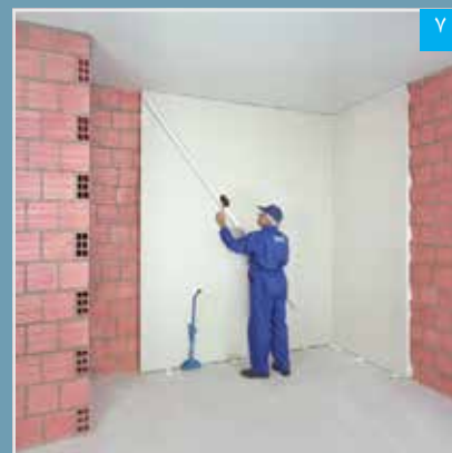
۷ نصب و تنظیم پنل، با پنل نصب شده مجاور
