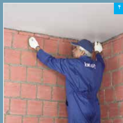
۳ علامت گذاری مسیر لایه پوششی بر روی سقف (با استفاده از ریسمان رنگی)
