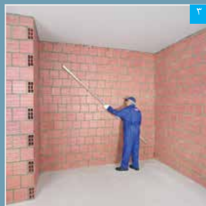
۸ شمشه گذاری به صورت مایل بر روی دیوار زمینه، جهت بررسی ناهمواری در طول دیوار
