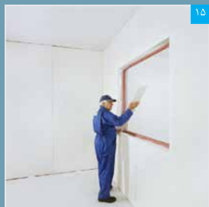
استقرار پنل نواری در ناحیه داخلی دور بازشوی پنجره
