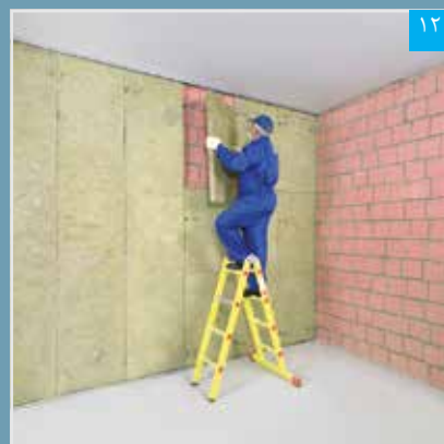
۱۲ اجرای عایق پشم معدنی
