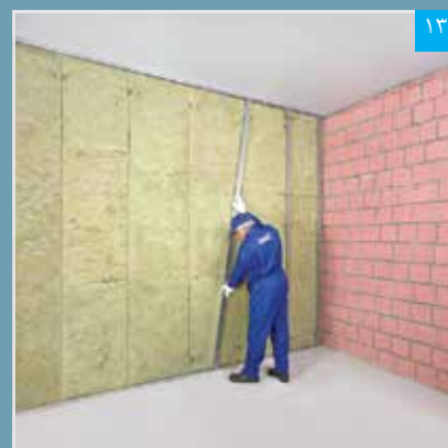
۱۳ استقرار سازه‌های قائم در سازه‌های هادی و میان براکت‌ها
