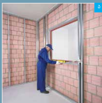
۵ تنظیم رانر قاب بندی تحتانی به وسیله تراز
