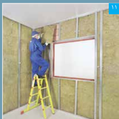
اجرای عایق پشم معدنی
