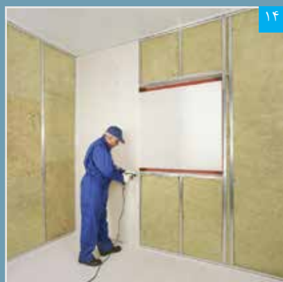
۱۴ نصب پنل بر روی زیرسازی
