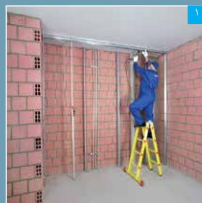
۱ اجرای قاب پیرامونی (به روش مشابه ساختار W625)
