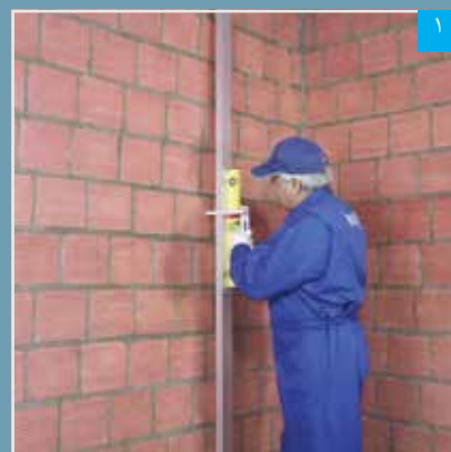
اندازه گیری میزان ناهمواری دیوار
