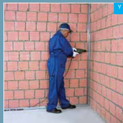
نصب اولین استاد بر روی ساختار جانبی
