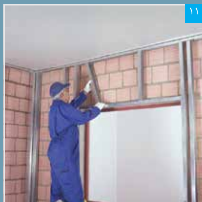
۱۱ استقرار استاده‌ها در رانر سقف و رانر قاب بندی فوقانی
