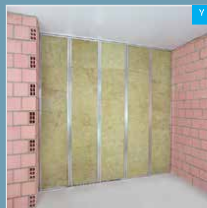
۵ لایه عایق تکمیل شده
