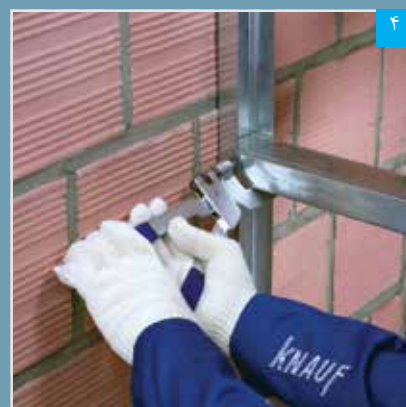
اتصال و تثبیت استاد به رانر (به وسیله پانچ، پرچ یا پیچ)
