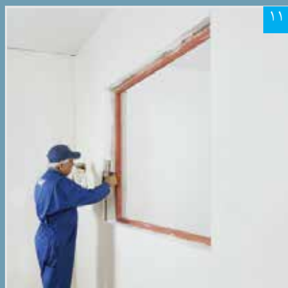
اجرای پرلایکس بین پنل و دیوار بنایی (دور تا دور بازشوی پنجره)
