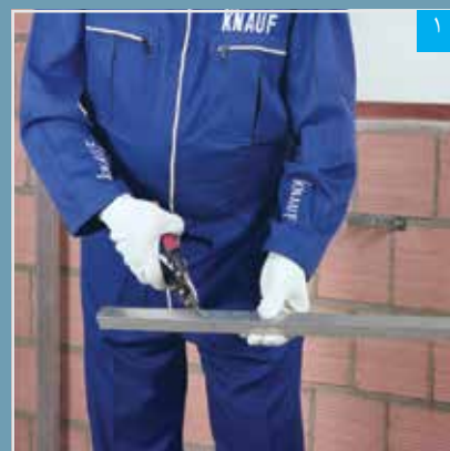
۱ برش انتهای سازه‌های افقی قاب بندی بازشوی پنجره (به اندازه ۲۰ سانتیمتر و به صورت فارسی بر)
