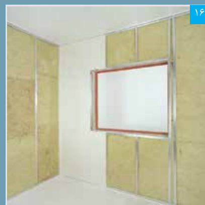
۱۶ در محل بازشوی پنجره، برش پنل به صورت «C» شکل صورت می‌گیرد
