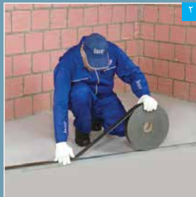
اجرای نوار عایق (یا دو ردیف خمیر درزبند) بر پشت جان رانر کف و سقف
