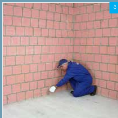
مشخص کردن محل نصب رانر کف با ریسمان رنگی
