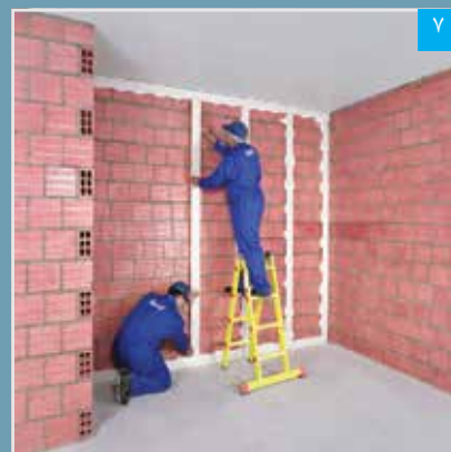
نصب کرم ها به فاصله حداکثر ۶۰ سانتیمتر از یکدیگر (مرکز به مرکز)
