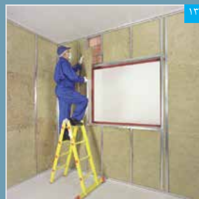
۱۳ اجرای عایق پشم معدنی
