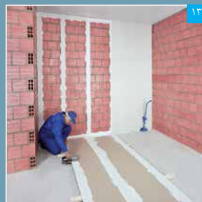
لایه نواری بتونه درزگیر را می توان بر پشت پنل ها اجرا نمود
