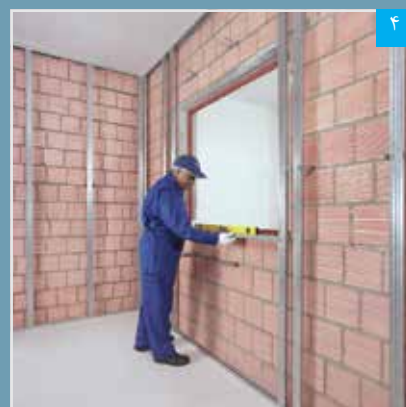
۴ تنظیم سازه قاب بندی به وسیله تراز
