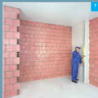
۴ بررسی تراز و تنظیم بودن پنل نصب شده با استفاده از شمشه و تراز
