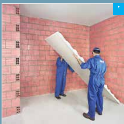
۲ پنل به سادگی توسط دو نفر قابل بلند کردن است
