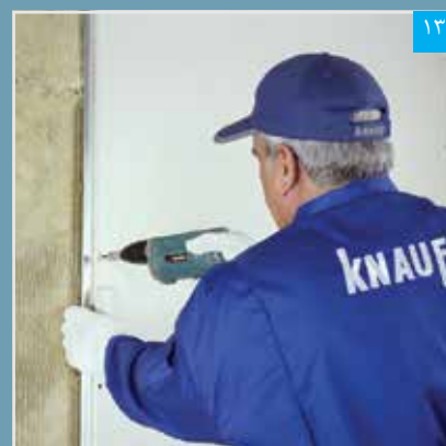
توجه: پنل‌ها باید در چپتی نصب شوند که لبه آزاد آن‌ها به سمت دهانه باز استاداها قرار گیرد
