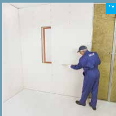
برش پنل به صورت «C» شکل (با استفاده از اره)
