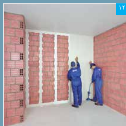
نصب پنل با استفاده از جک نگهدارنده
