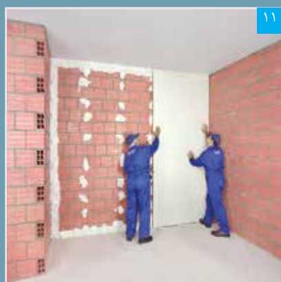
استقرار پنل بر روی دیوار زمینه
