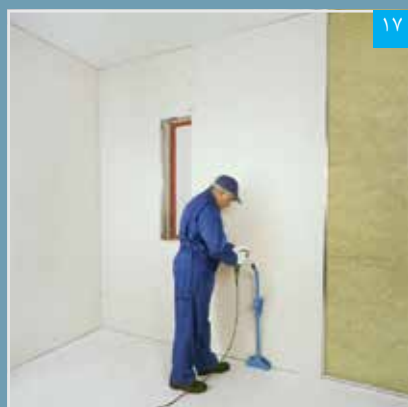
۱۷ نصب پنل بر روی زیرسازی
