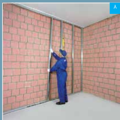
اجرای استاداها (به صورت شاقولی)
