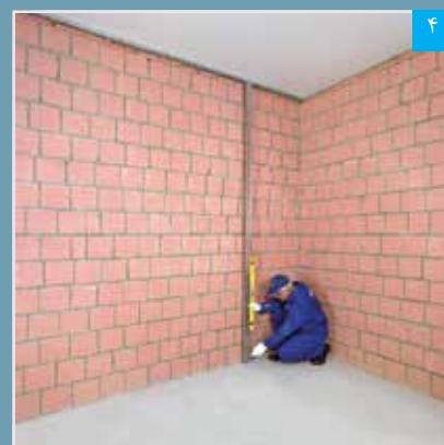
۴ انتقال تصویر سازه هادی سقف به کف (با استفاده از استاد و تراز)
