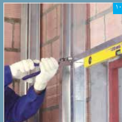
۱۰ اتصال رانر قاب بندی فوقانی به استاد به وسیله پانچ، پرچ یا پیچ (به جهت برش ۴۵ درجه توجه شود)
