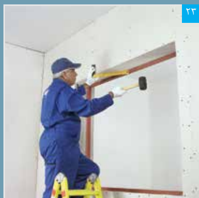
تنظیم پنل نواری (گونی کردن)
