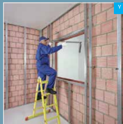
۷ استقرار سازه قاب بندی فوقانی (به جهت خم‌ها توجه شود)
