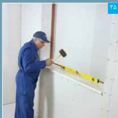
نصب و تنظیم سنگ کف پنجره
