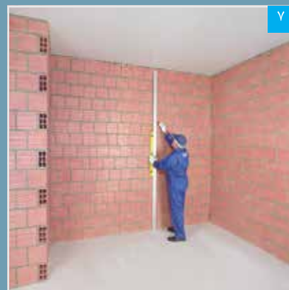
۵ مشخص کردن محل اجرای چانه های پرفلیکس بر روی دیوار زمینه
