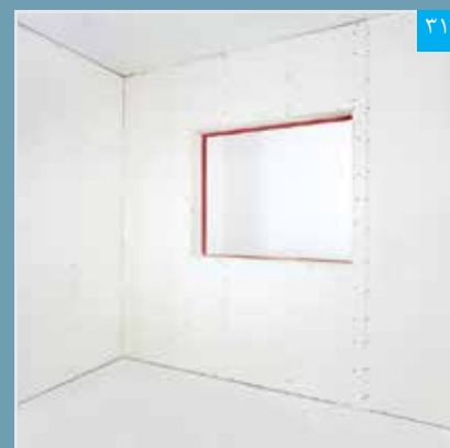
۳۱ پوشش کاری تکمیل شده در ناحیه بیرونی و درونی بازشوی پنجره
