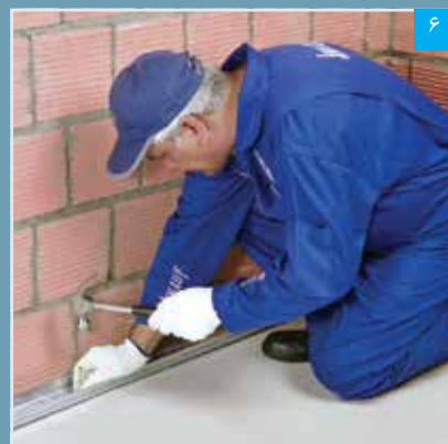
نصب رانر کف
