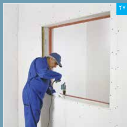
اتصال پنل نواری به سازه قاب بندی تحتانی
