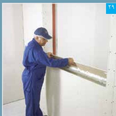
استقرار پتل نواری در ناحیه داخلی دور بازشوی پنجره
