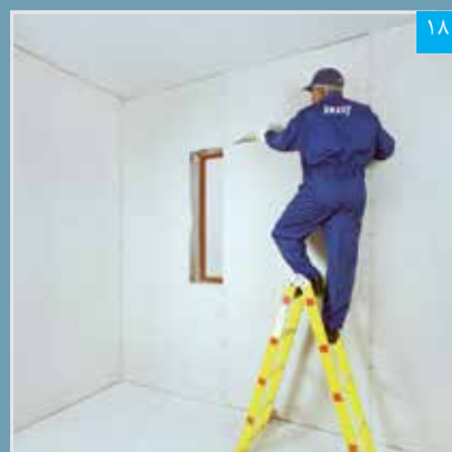
۱۸ برش پنل به صورت «C» شکل (با استفاده از اره)
