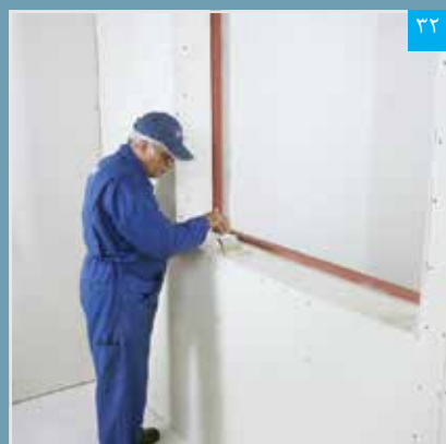
۳۲ اجرای پرایمر بر روی سطح پتل
