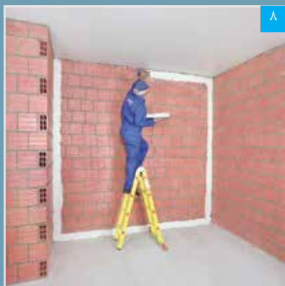
۶ اجرای پرفلیکس به صورت نوار پیوسته در حاشیه پیرامونی دیوار زمینه
