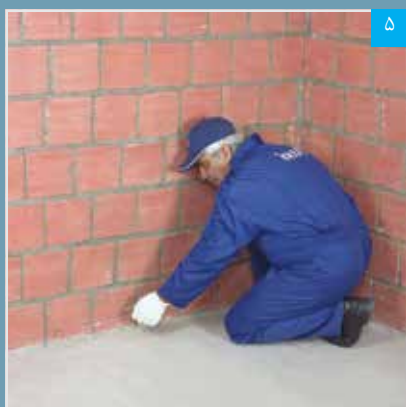
۴ علامت گذاری مسیر لایه پوششی بر روی کف (با استفاده از ریسمان رنگی)
