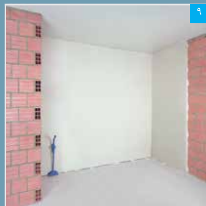
۹ پوشش کاری تکمیل شده
