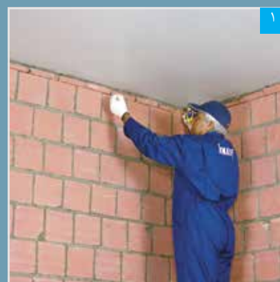
۱ مشخص کردن محل نصب سازه هادی سقف با ریسمان رنگی
