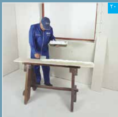
اجرای پرلایکس بر پشت پنل نواری (برای پوشش کاری ناحیه داخلی دور بازشوی پنجره)
