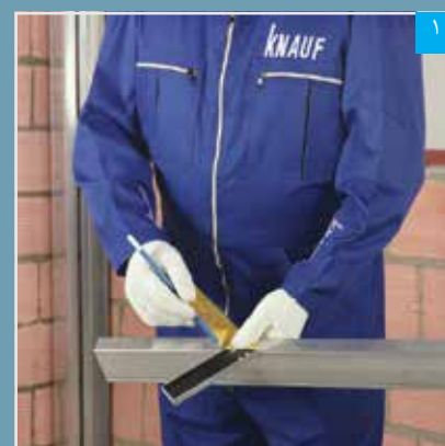
۱ علامت گذاری بر روی رانر قاب بندی بازشوی پنجره (به اندازه ۲۰ سانتیمتر و به صورت فارسی بر)
