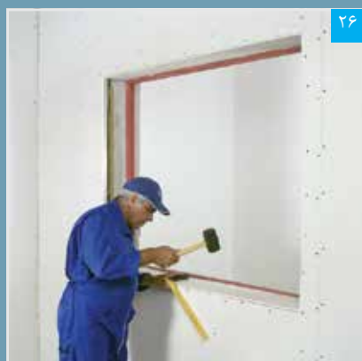
تنظیم پنل نواری (گونی کردن)
