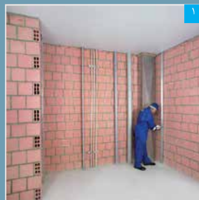
نصب اولین رانر بر روی ساختار جانبی
