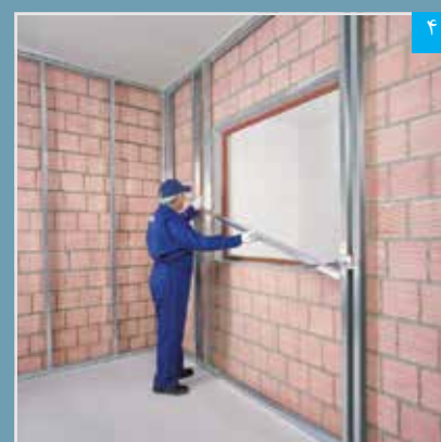
۴ استقرار رانر قاب بندی تحتانی (به جهت خمها توجه شود)
