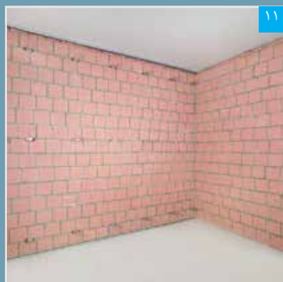
۱۱ براکت‌های نصب شده
