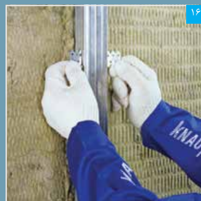
۱۶ خم کردن طول اضافه بال‌های براکت (توجه: لایه عایق در پشت سازه‌ها قرار می‌گیرد)
