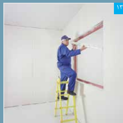
استقرار پنل نواری در ناحیه داخلی دور بازشوی پنجره
