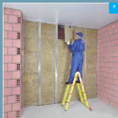
۸ اجرای عایق پشم معدنی (توجه: در فاصله میان استادهای)
