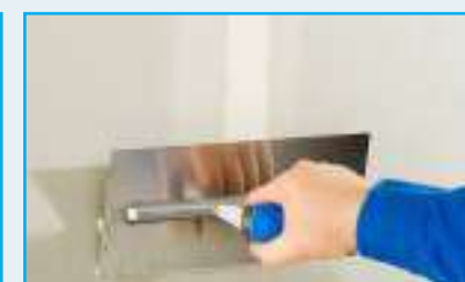
درزگیری و آماده سازی سطوح
