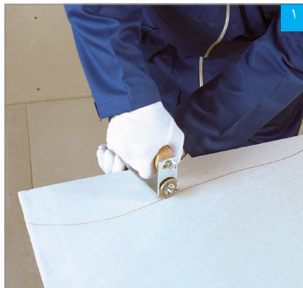
اجرای برش موج‌دار با دستگاه برش قرقه‌ای
