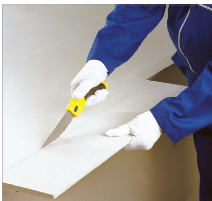
برش پنل با اره دستی
