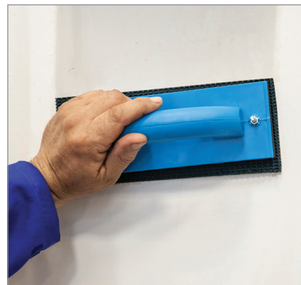
مرطوب کردن سطح دیوار با اسفنج نمدار
