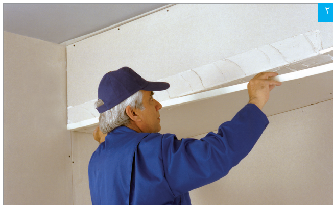
قرار دادن نوار درزگیر بر روی بتونه
