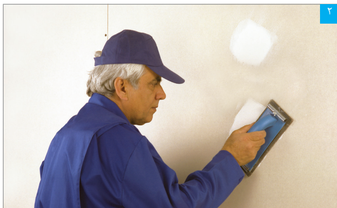
پرداخت سطح بتونه خشک
