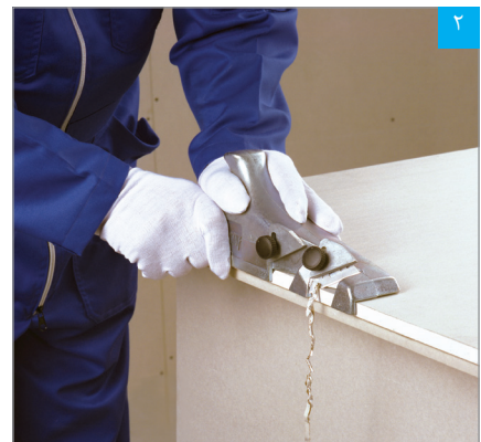
اجرای پخ با پخ زن
