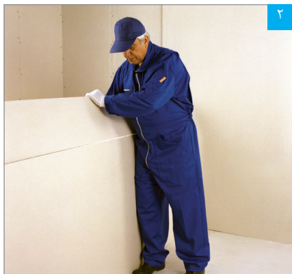
شکستن پنل در محل برش
