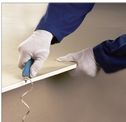
اجرای پخ با تیغ برش
