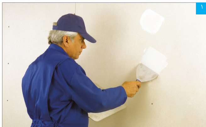
اجرای بتونه در محل پیچ‌ها
