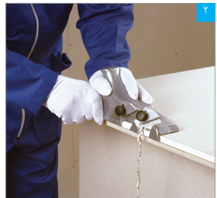
اجرای پخ با پخ زن
