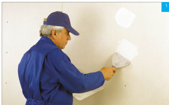
اجرای بتونه در محل پیچ‌ها
