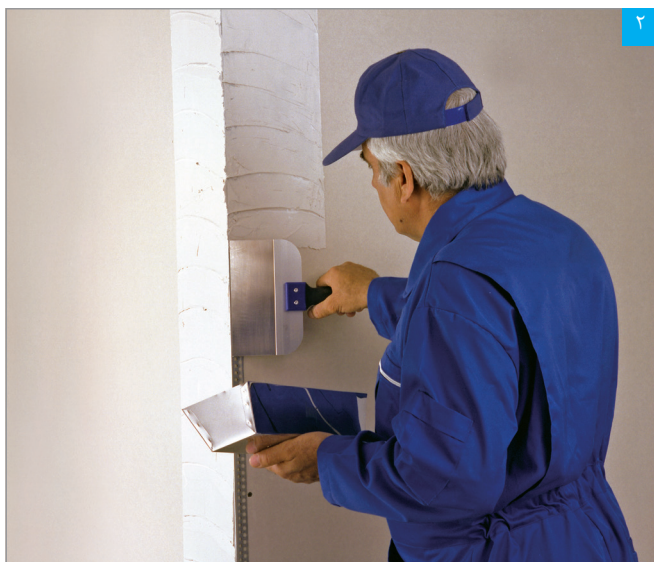
اجرای بتونه روی سازه محافظ گوشه
