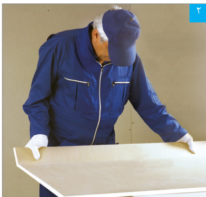
شکستن پنل در محل برش
