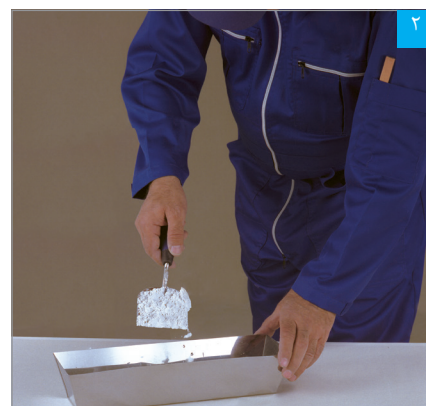
ریختن پودر بتونه در آب
