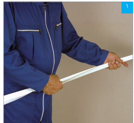
خم کردن نوار درزگیر با دست
