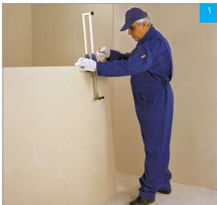
برش پنل با دستگاه برش طولی
