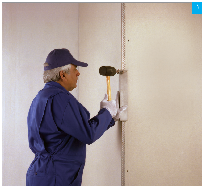
نصب سازه محافظ گوشه با دستگاه کرنبید کوب
