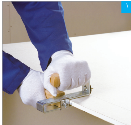
برش پنل با دستگاه برش قرقه‌ای
