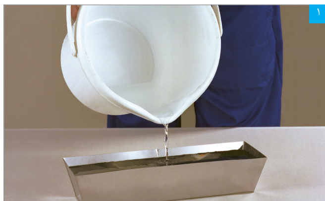
ریختن آب در ظرف تهیه بتونه
