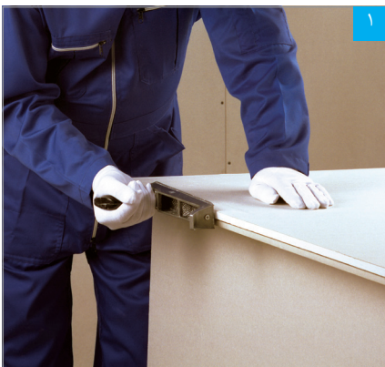
پرداخت لبه برش‌خورده با رنده
