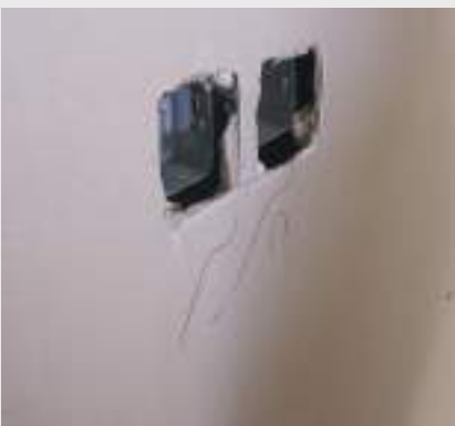
برش نامناسب پنل
