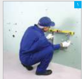
علامت گذاری محل نصب دریچه (با استفاده از قاب دریچه)
