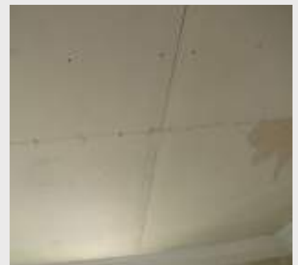
عدم رعایت حصارچینی در پنل‌ها
