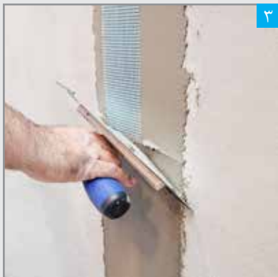
نوار درزگیر توسط ماله در ملات دفن می شود.
