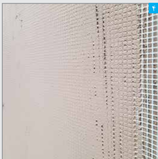
اجرای ملات بر روی مش
