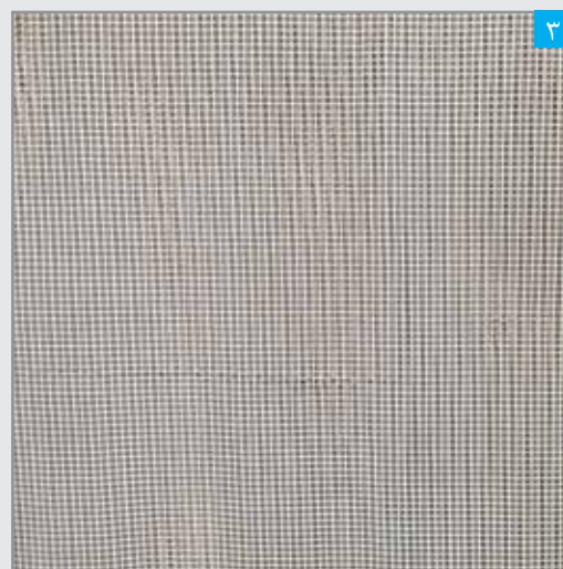
مسلح کردن کل سطح توسط مش مخصوص
