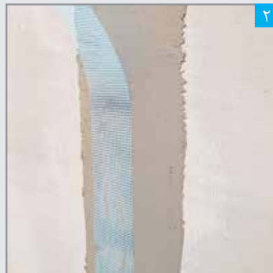
نوار درزگیر ۱۰ سانتی متری بر روی درز قرار می گیرد.
