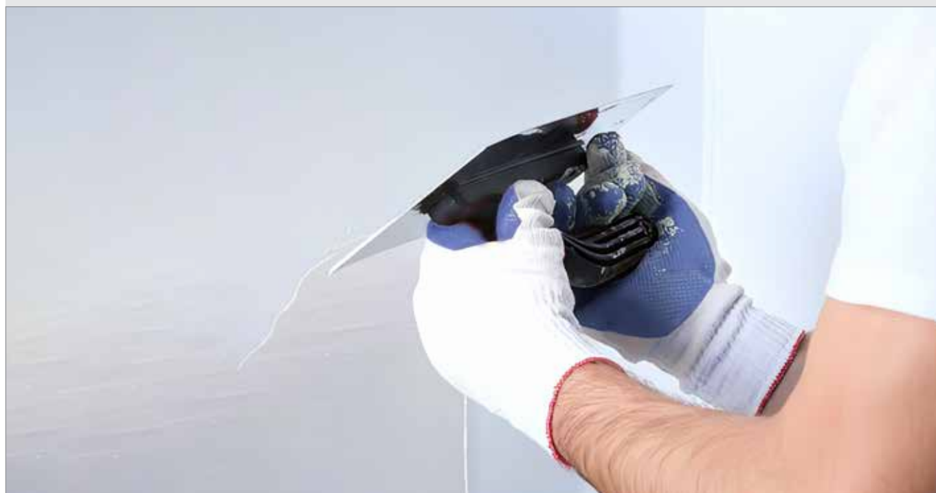
اجرای اسکیم لایت به صورت یک لایه نازک حداکثر ۲ تا ۳ دقیقه بر روی سطح کار
