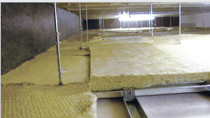
عایق کاری پیلوت
