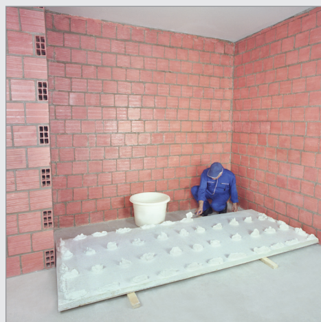
نشان دادن چانه‌های اسکیم‌لایت بر روی پنل‌ها
