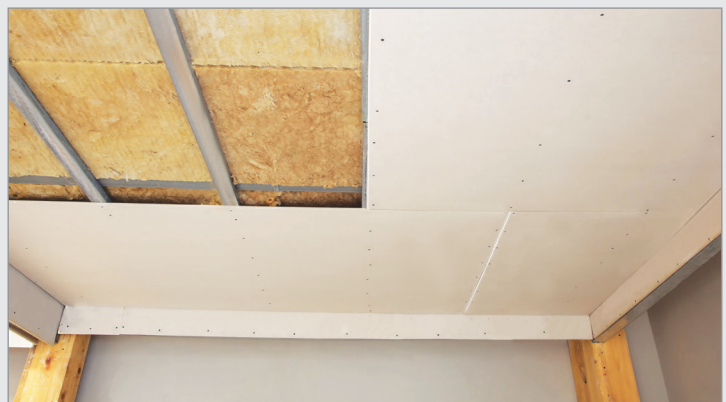
عایق کاری سقف ساختمان
