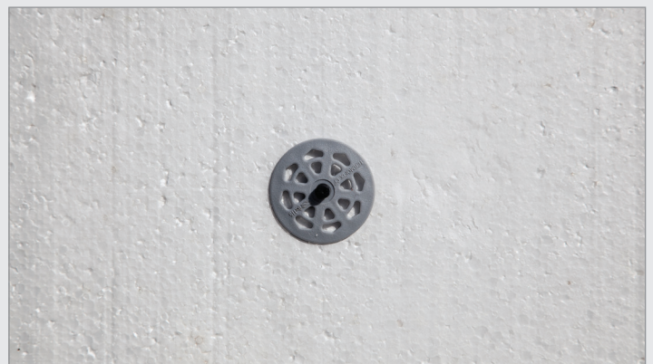
نصب بست‌های Termofix
