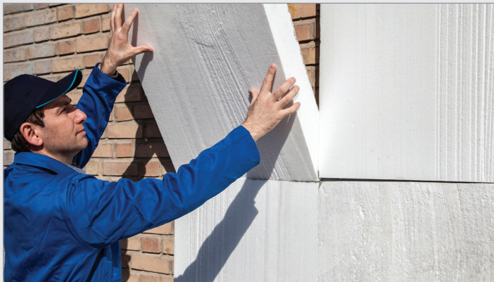
نصب قطعات عایق بر روی دیوار زمینه
