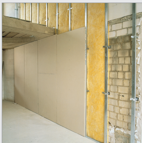
عایق‌کاری حرارتی و صوتی دیوارهای خارجی ساختمان
