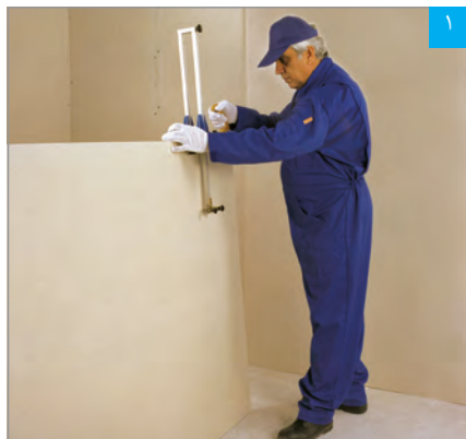
برش پنل با دستگاه برش طولی
