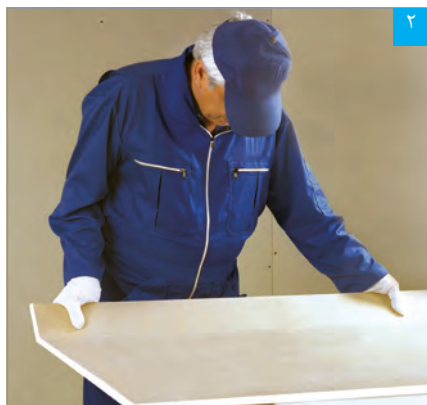
شکستن پنل در محل برش
