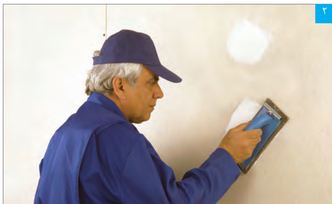
پرداخت سطح بتونه خشک
