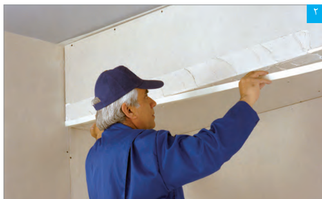
قرار دادن نوار درزگیر بر روی بتونه
