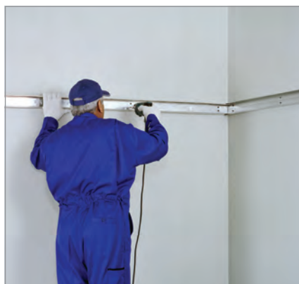
نصب سازه تراز باربر
