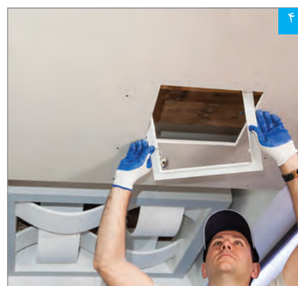
۴ قرارگیری قاب پیرامونی دریچه
