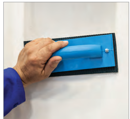
مرطوب کردن سطح دیوار با اسفنج نمدار
