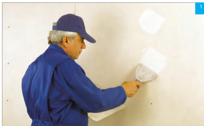
اجرای بتونه در محل پیچ‌ها
