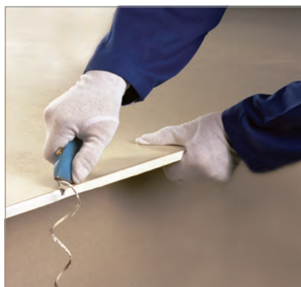
اجرای پخ با تیغ برش
