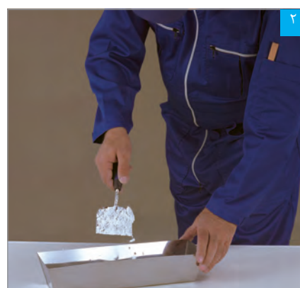
ریختن پودر بتونه در آب
