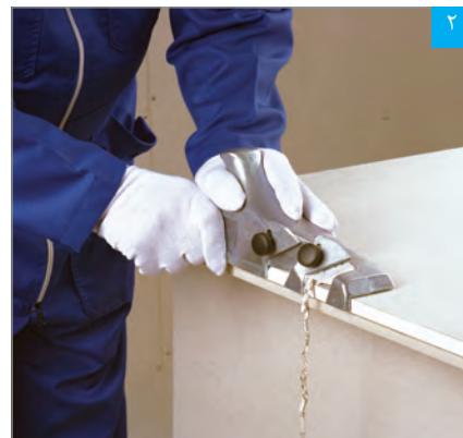
اجرای پخ با پخ زن
