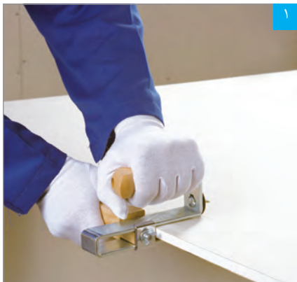
برش پنل با دستگاه برش قرقره‌ای
