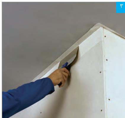
۳ بتونه کاری در فصل مشترک دیوار خشک و سقف بنایی
