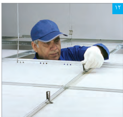
قراردادن گیره‌های مخصوص نگهدارنده تایل
