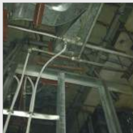
عدم اتصال رانر بالایی به سقف یا زیرسازی قوطی
