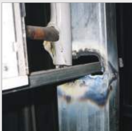
برش سازه با ابزار نامناسب
