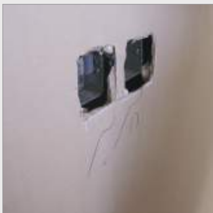
برش نامناسب پنل
