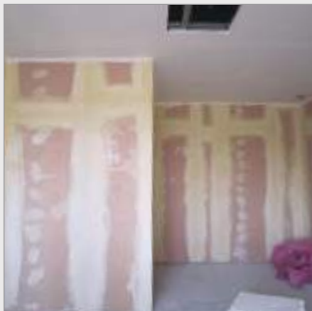
استفاده از بتونه و آماده سازی سطوح برای رنگ آمیزی به روش سنتی
