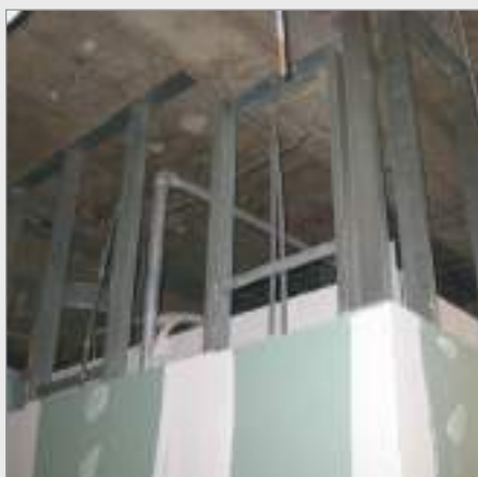
عدم امتداد یافتن پنل‌ها تا سقف اصلی
