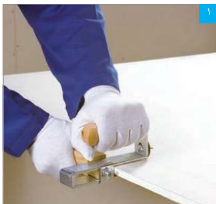
برش پنل با دستگاه برش قرق‌های
