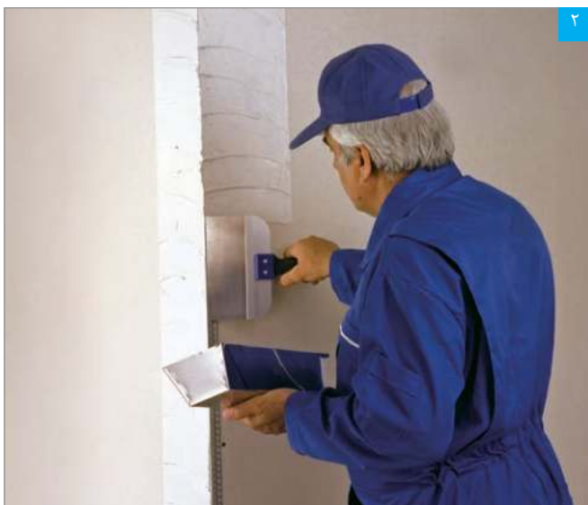
اجرای بتونه روی سازه محافظ گوشه
