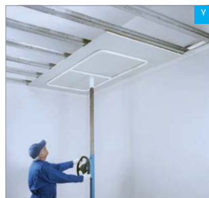
استقرار پنل با استفاده از بالابر
