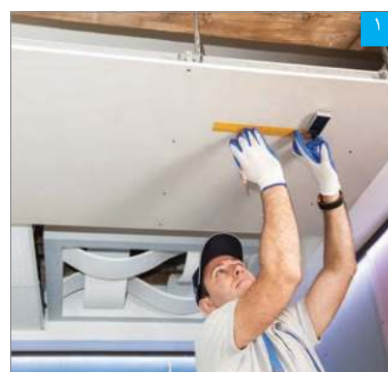
تعیین محل نصب دریچه و ترسیم ابعاد بر روی پنل
