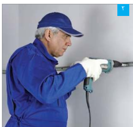
نصب سازه تراز
