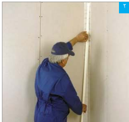
قرار دادن نوار درزگیر بر روی بتونه
