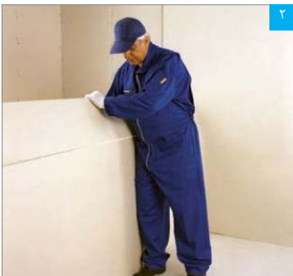
شکستن پنل در محل برش
