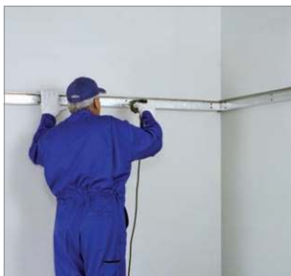
نصب سازه تراز باربر
