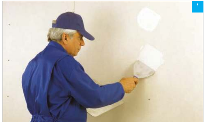
اجرای بتونه در محل پیچ‌ها
