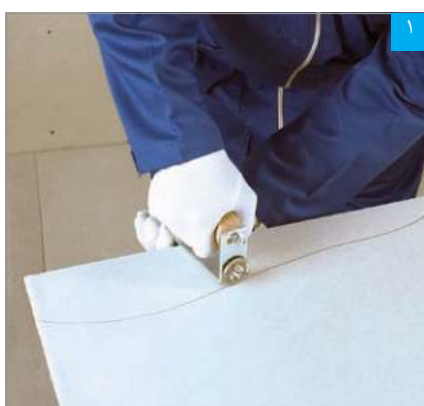
اجرای برش موج‌دار با دستگاه برش قرق‌های
