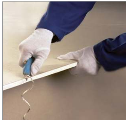
اجرای پخ با تیغ برش
