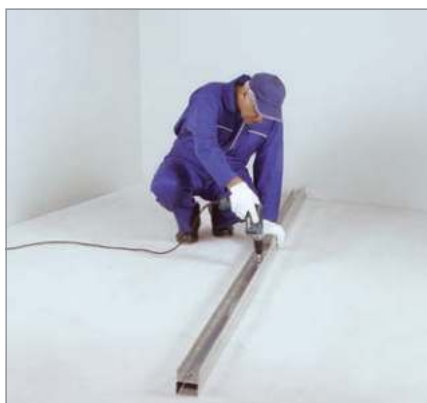
اجرای سازه سقفی دوتایی
