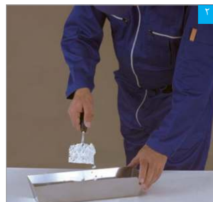
ریختن پودر بتونه در آب
