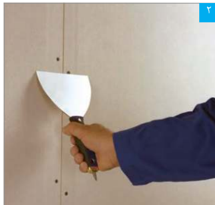
۲ بررسی بیرون‌زدگی پیچ‌ها با کاردک
