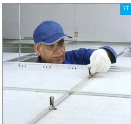
قراردادن گیره‌های مخصوص نگهدارنده تایل
