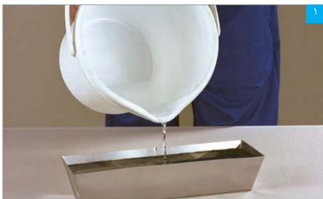
ریختن آب در ظرف تهیه بتونه
