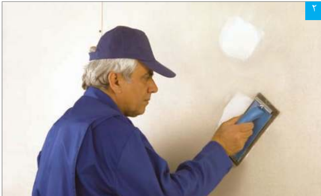
پرداخت سطح بتونه خشک
