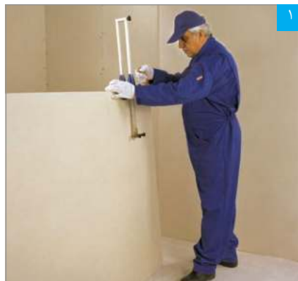
برش پنل با دستگاه برش طولی
