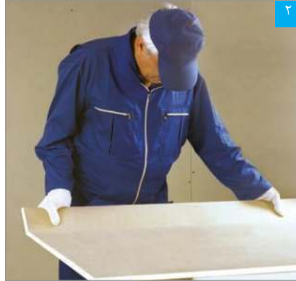
شکستن پنل در محل برش
