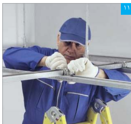
اتصال سازه پتل‌خور به سازه باربر توسط قطعه اتصال کامل
