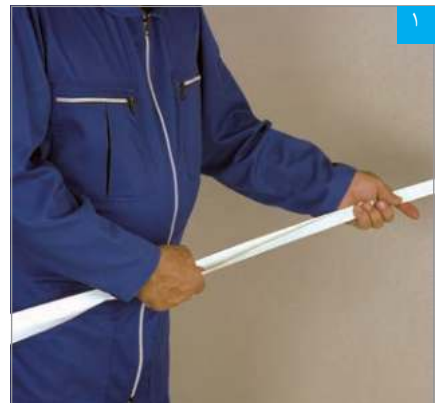
خم کردن نوار درزگیر با دست
