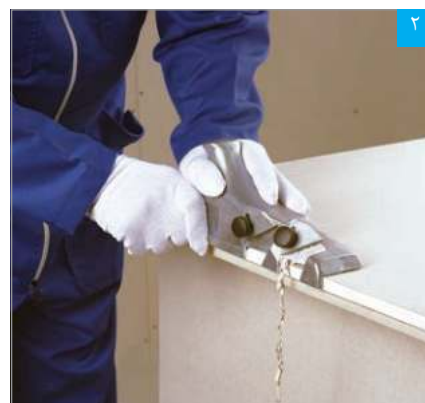
اجرای پخ با پخ زن
