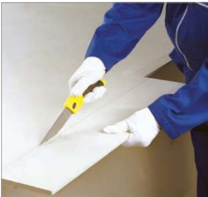
برش پنل با اره دستی
