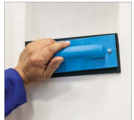
مرطوب کردن سطح دیوار با اسفنج نمدار
