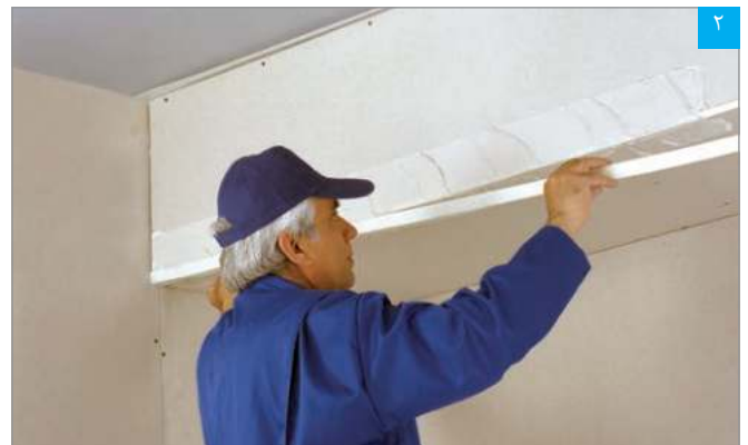
قرار دادن نوار درزگیر بر روی بتونه
