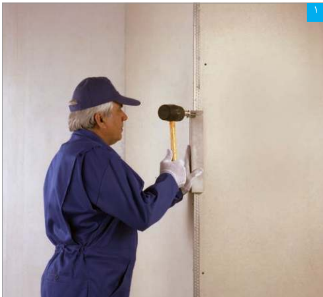
نصب سازه محافظ گوشه با دستگاه کرنربیدکوب
