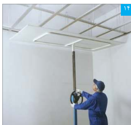
استقرار پتل با استفاده از بالابر
